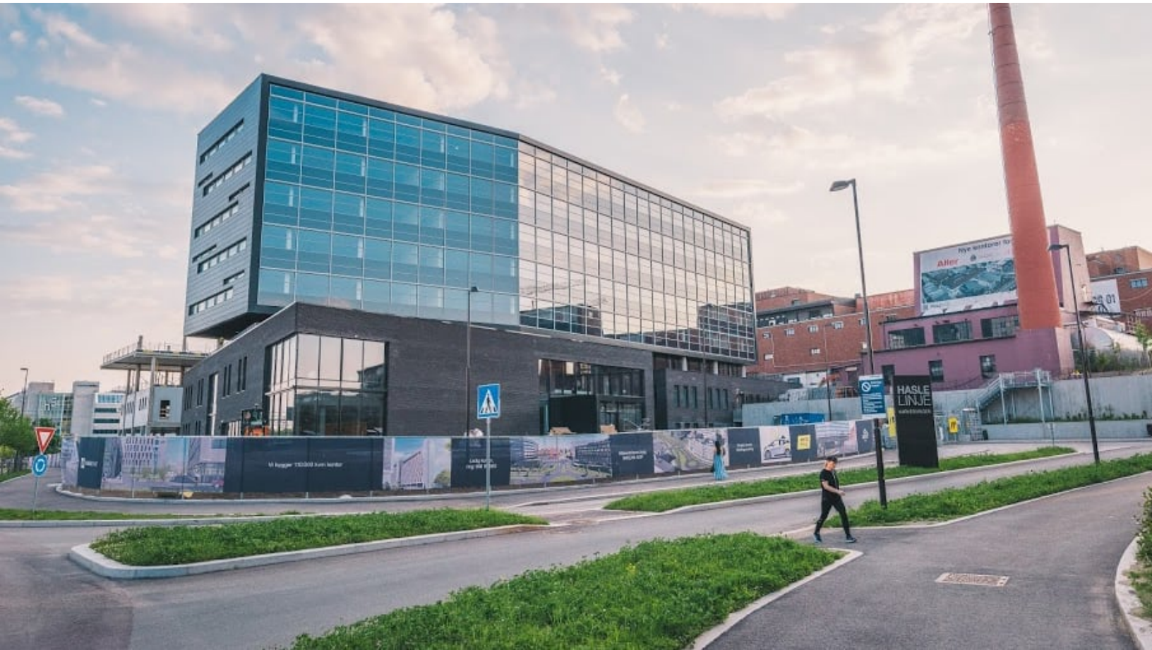
COWIs nye hovedkontor, Portalbygget på HasleLinje.
